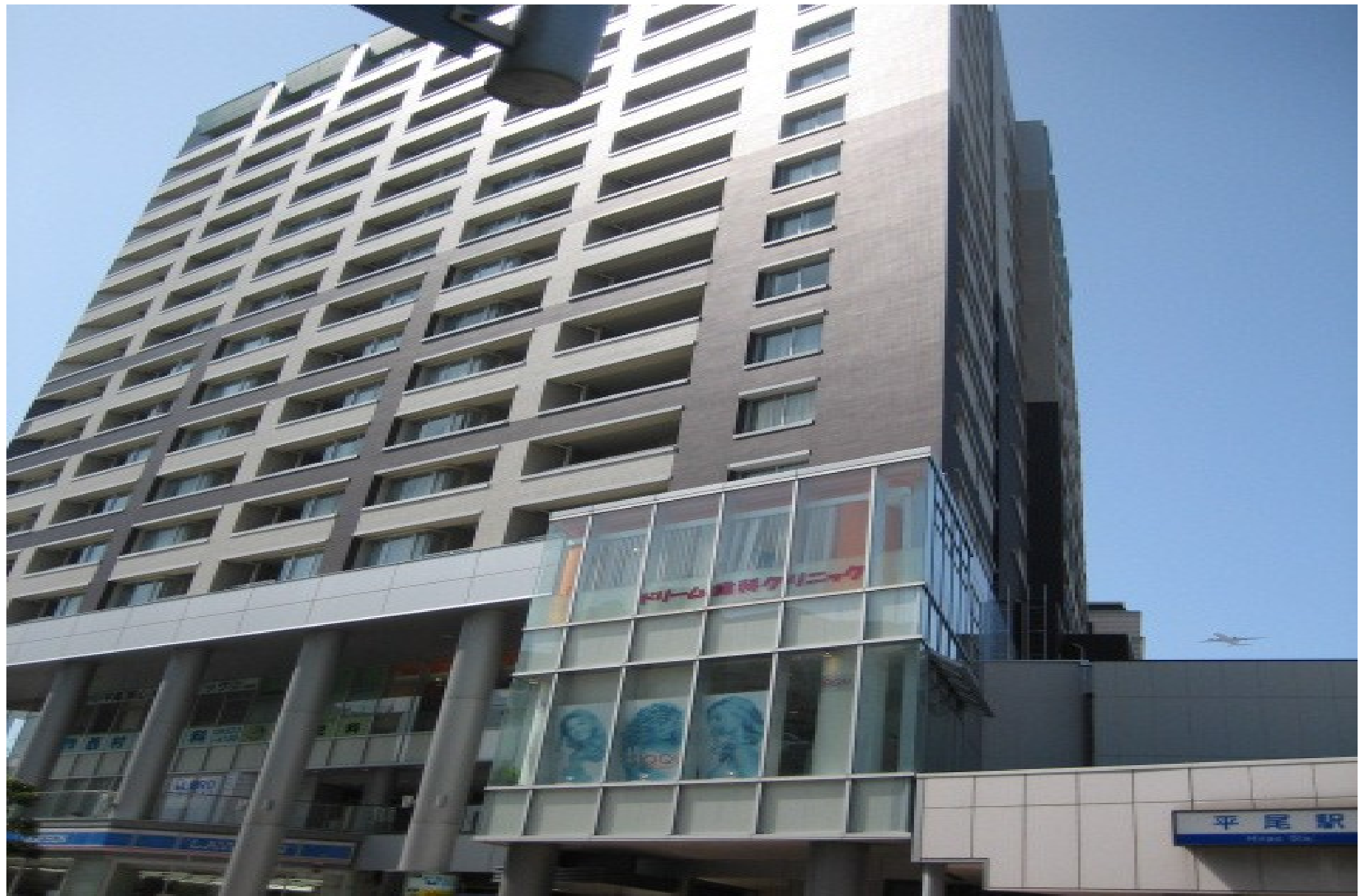
西鉄平尾駅ビル 増築工事
